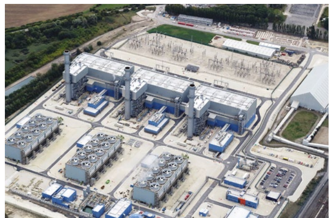
West Burton B CCGT site
