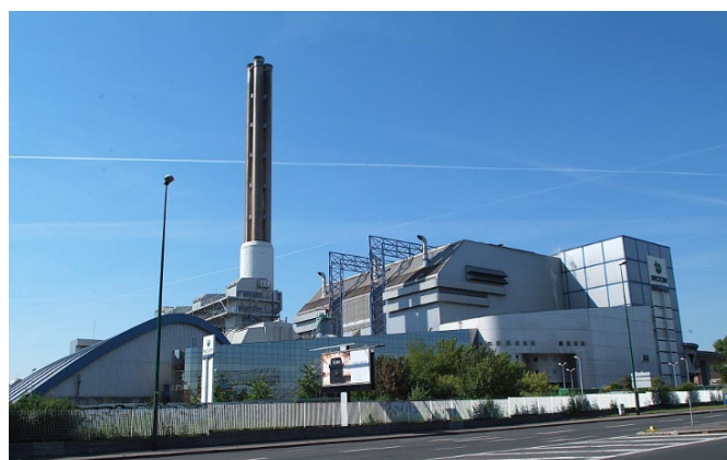
Usine d'incinération, France
