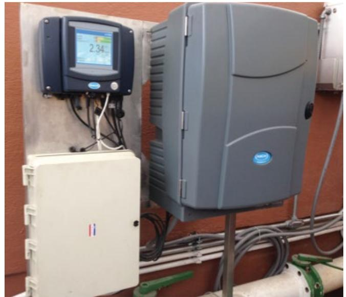
Fig. 1: Sistema RTC-P
