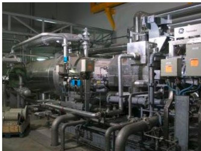
*Turbina de vapor en una planta de incineración*
