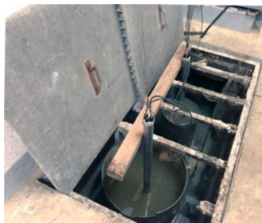
2台のハック製センサーは、カシスの下水処理場の2つの流入口で、生下水中の溶存 H 2 S を恒常的にモニタリングしていました。
