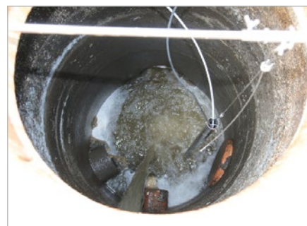
Εικόνα 1. Η τοποθέτηση ενός αισθητήρα υγρής φάσης απευθείας στη ροή των υγρών αποβλήτων επιτρέπει μια πληρέστερη απεικόνιση της πραγματικής συγκέντρωσης του H 2 S σε αυτήν τη ροή. Η διαδικασία αυτή υπερτερεί των αισθητήρων αέριας φάσης μόνο, οι οποίοι μπορεί να μην απεικονίζουν ολόκληρη την έκταση του προβλήματος με βάση την απόσταση μεταξύ του νερού και του αισθητήρα ή το μέγεθος ανατάραξης σε υδρομαστευτικά φρέατα.
