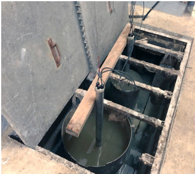
Figura 3. La possibilità di installare un sensore a doppia fase in modo permanente o temporaneo, direttamente nelle acque reflue o nell'aria sopra di esse, offre agli operatori degli impianti di trattamento delle acque reflue la massima versatilità per la quantificazione di potenziali problemi di odore, rischi per la sicurezza o problemi di processo in tutto l'impianto e la catena di trattamento.
