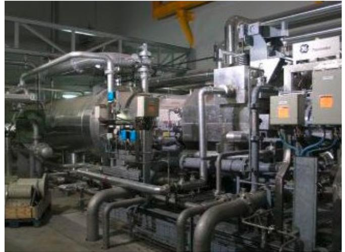
*Dampfturbine in einer Verbrennungsanlage*
