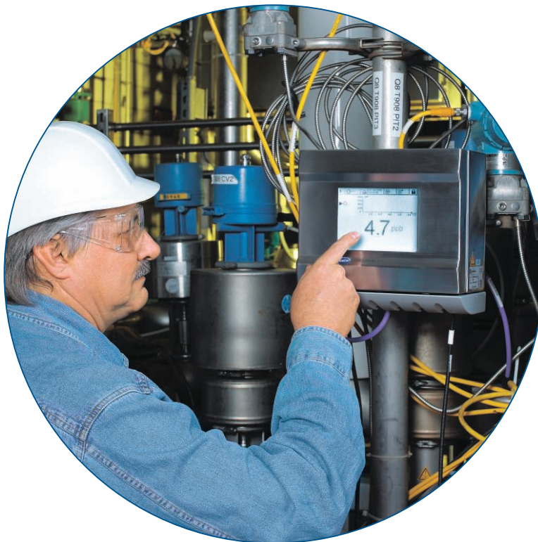
Contrôle des niveaux d'oxygène avec le capteur K1100 et le transmetteur 410 ORBISPHERE
