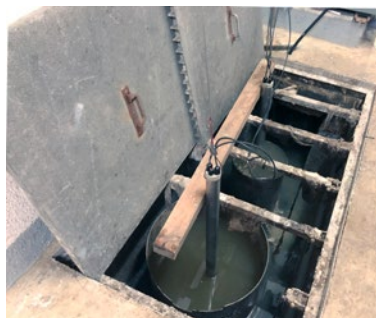
Δύο αισθητήρες H_2S της Hach παρακολουθούσαν μόνιμα το διαλυμένο H_2S στα ακατέργαστα υγρά απόβλητα σε δύο πηγές εισρεόντων στη μονάδα επεξεργασίας λυμάτων στο Cassis.
