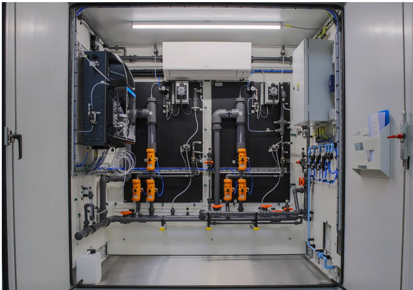
Binnen- en buitenkant van de geïntegreerde oplossing voor de toxiciteit van influent
