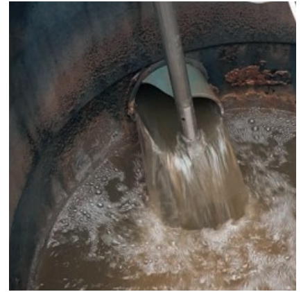
この ハック \text{H}_2\text{S} センサーは、井戸の入口の原水に直接配置されました。
