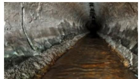
Figura 3. L'acido solforico che attacca i carbonati nelle tubazioni di cemento armato ne compromette la funzione di agenti leganti, trasforma le pareti dei condotti in gesso friabile e corrode l'acciaio di rinforzo.
